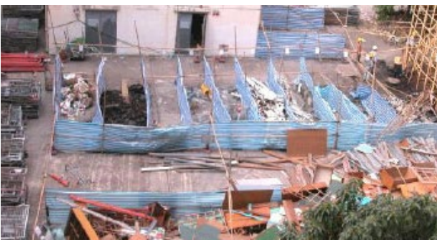
圖 121 工地建築廢物分類設施 (來源：環境保護署)
