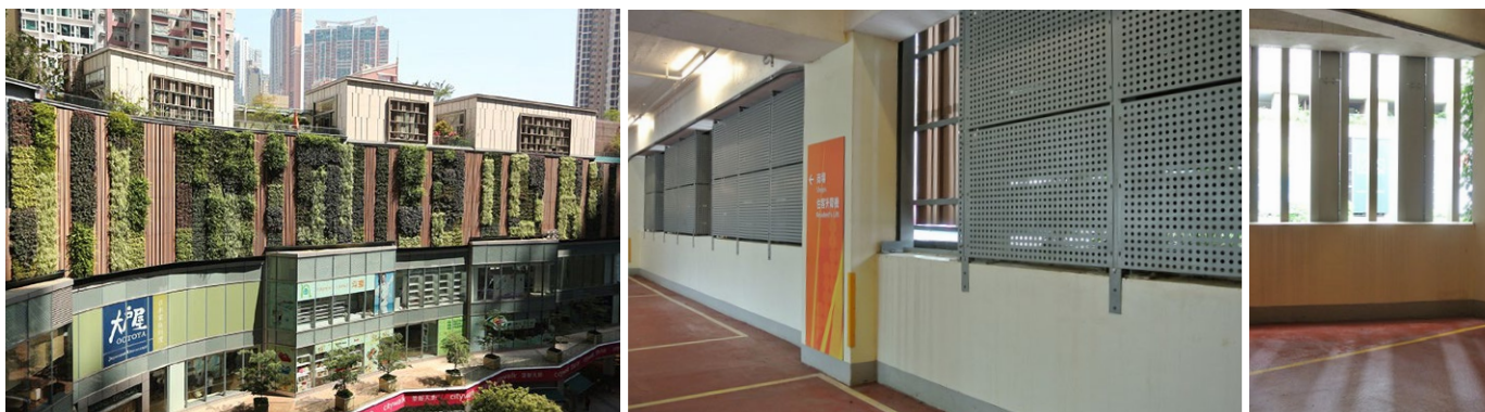
圖 49 綠化牆用於荃灣荃新天地商場停車場的外牆設計（來源：信和集團）
