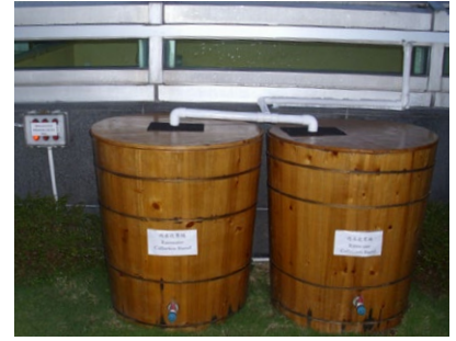
圖 110 簡易雨水蓄集系統
