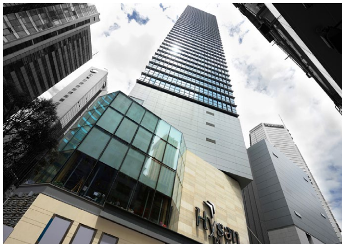
圖 5 希慎廣場，綠建環評 [1.1版] 新建建築項目 — 鉑金評級
