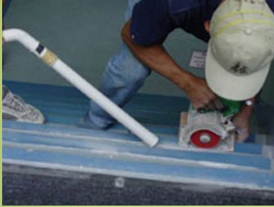
圖 135 使用吸塵機減少塵埃 (來源：環境保護署)
