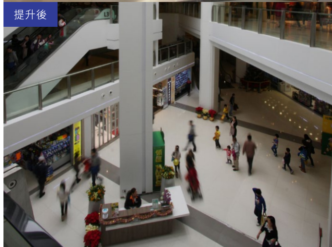
圖 40 屯門良景廣場的改造工程 (來源：領匯管理有限公司)
