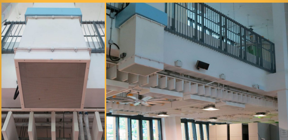
圖 76 零碳天地內的捕風器 (來源：零碳天地)
