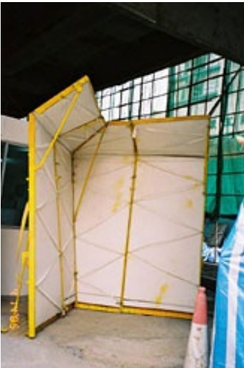
圖 132 可消減噪音的活動式隔音屏障（來源：環境保護署）
