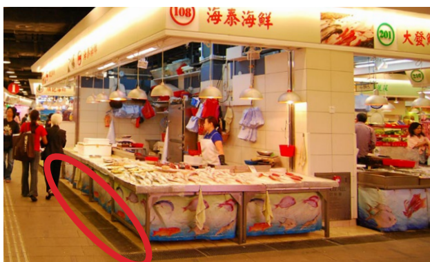
圖 182 設置在店鋪周邊的排水溝渠 (來源:領匯管理有限公司)
