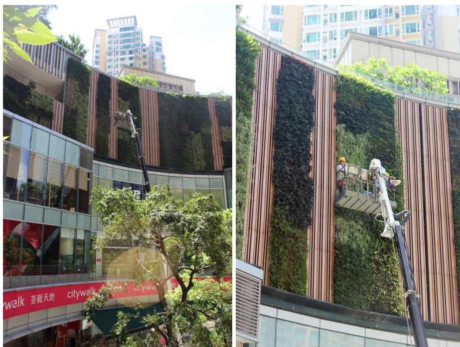
圖 50 荃灣荃新天地建築物正面綠化牆的保養（來源：信和集團）
